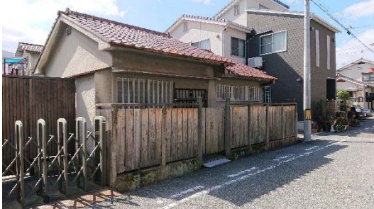
図-12 管理されている空家（鳴尾1丁目）
