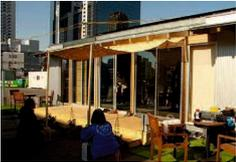
夏の日射遮蔽のため、日中は可動式断熱建具を閉じます。また、南側のガラスの庇からの日射を遮蔽するために、庇下にすだれを設けます。
