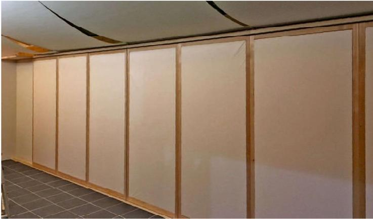
南北のガラスの窓の内側に断熱建具（引き戸）を設けました。40mmの断熱材（ポリスチレンフォーム）を障子で覆っています。日射熱取得のなくなる夕方以降、外気温の下がる夜間の熱損失を抑えて、室内の温度低下を防ぎます。建具の熱抵抗は 1.0m<sup>2</sup>K/W（窓と合わせた、U値は 0.68W/m<sup>2</sup>K）となります。
