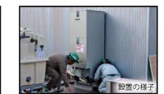
大気熱を利用してお湯を沸かす、地球環境への負荷を抑えた自然冷媒ヒートポンプ給湯器。電気エネルギーのみの場合と比べて、電力消費量が約1/3に抑えられます。エコキュートと高断熱浴槽などにより給湯消費電力を44%削減。
