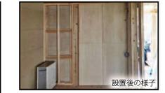
電力会社から買う電気、もしくは太陽光発電の電気を蓄えておく機器。停電時には非常電源として電気を使用することができます。
