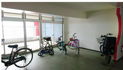
図-4 19 号棟の中廊下のアルコーブ
