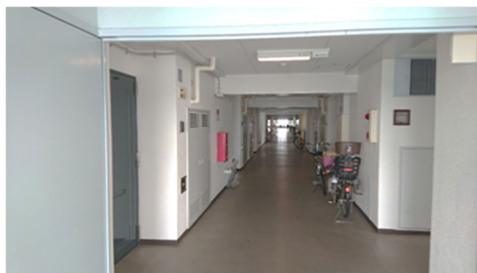
図-3 31 号棟の中廊下の様子
